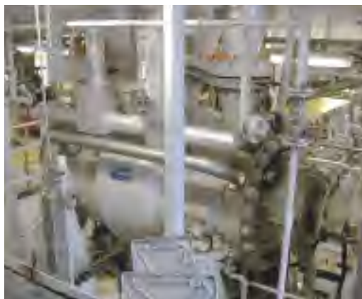
Compresor (Nuovo Pignone) en la plataforma fuera de la costa Njord (Norsk Hydro) con un sello de gas DGS9/130 de Burgmann (disposición tandem) y un CSR para sellar el aceite del rodamiento. En operación sin problemas desde 1998. P_1 = 26 \dots 48 \text{ bar a} ; n = 12,495 \text{ min}^{-1} ; fluido: gas natural.
