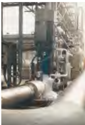
Bomba vertical en línea (Worthington) para vaciar un depósito de gas liquidificado de etileno. Sistema de sellado doble con MFLWT80F-D1/53 (API 682, Plan 53). ( p_1 = 2 bar; presión de entrada = 23 bar; p_2 = 6 bar; t_1 = -103 °C; n = 3,000 min -1 ).
