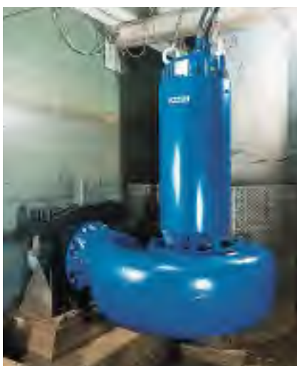
Bomba sumergible (ABS) instalada en posición estacionaria en un tanque de desborde de aguas negras. Esta está sellada con un MG1 de Burgmann en arreglo tandem. ( Q = \dots 6,500 \text{ m}^3/\text{h} ; H = \dots 60 \text{ m} )
