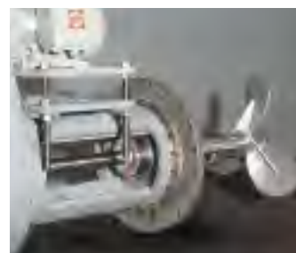
Bomba de circulación de suspensión de lavado (KSB-KWP) con un sello mecánico tipo HR321/290 de Burgmann.
