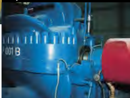
Bombas Principales (Worthington) en el proyecto RWTS, selladas con sellos HSHV1/220 de Burgmann (izquierda).
