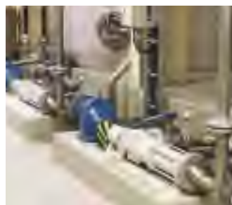
Bombas de tornillo excéntrico (Netzsch) con MG155 en terminado de papel.
