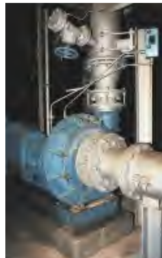
Bomba de evacuación de residuos (Habermann) con sello tandem HR222 S1/140 y QFT 2000.
