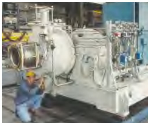
Compresor de amoníaco (Turbo Sulzer) en Norsk Hydro, Trinidad. El sistema del compresor fue equipado con un DGS de Burgmann, independiente de la dirección de rotación, en una disposición consecutiva con laberinto intermedio interno y un sistema de gas buffer de Burgmann. El sistema ha estado funcionando sin problemas desde 1995. d_1 = 100 \text{ mm} ; p = 4.7 \text{ bar a} ; n = 15,850 \text{ min}^{-1} ; fluido: amoníaco.
