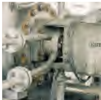
Bomba de retorno (KSB) con sello tandem tipo H75S2/60-H75F2/55 de Burgmann de acuerdo con el Plan 52 de API 682 para sellar hidrocarburos de C 4 . Fluido buffer: metanol.
