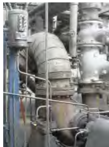
Sello mecánico de Burgmann tipo MFLW85S20 para sellar aceite de gas con sulfuro en una bomba de Ruhrpumpen. Temperatura de 217 °C, presión de 2.3 bar.
