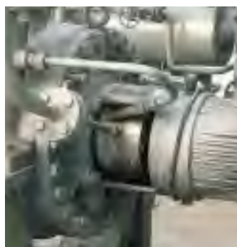
Bomba (Ruhrpumpen) con sello tandem tipo H75S2-H75F2 de Burgmann de acuerdo con el Plan 52 de API 682. Fluido: fracción de C 3 ; fluido buffer: metanol.
