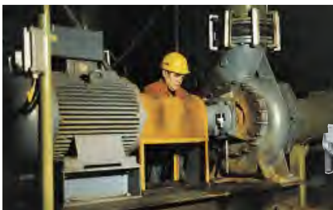
Bombas Anti-obstrucciones (KSB, KWP) con sello mecánico tipo MFL85N de Burgmann ( Q_{12}Q_1 , V T_6G_1 ) en un sistema de aguas residuales biológico de cinco etapas en funcionamiento para DA Union-Kraftstoff AG, Wesseling, para la eliminación bioquímica de nitrógeno en aguas residuales de refinería enriquecidas con amoníaco. La vida útil de estos sellos en arreglo sin conexiones está entre 3 y 4 años en las 30 bombas instaladas. ( d_1 = 53 \dots 90 \text{ mm} ; p_1 = 2 \dots 4.5 \text{ bar} ; t = 20 \dots 40 \text{ }^\circ\text{C} ; n = 950 \dots 1,450 \text{ min}^{-1} ).
