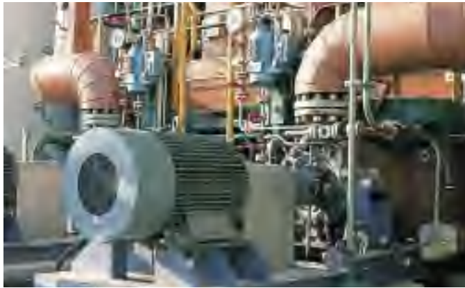
Sello mecánico Burgmann tipo MFLWT80/S1FD/58 E3 con sistema de termosifón TS2000/M073A1 para sellar óxido de etileno (bombas Sulzer).
