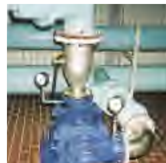
Bomba de agua potable (KSB, MTC D 100) con sello tipo H176N/50 de Burgmann.
